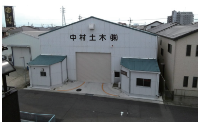
本社丸セパアングル保管場所
