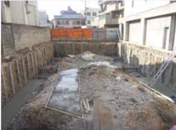
施工機が壁面に平行移動しながらソイルセメント壁を造成します。1工程のスパンが長く(5～8m)一度に施工するのでラップする箇所が少なく止水性が高くなります。ソイルセメント壁の深さが自由に設定・施工出来ます。従来より効率よく施工出来る為、安価に出来ます。隣地境界線 or 構造物より約 100mm のクリアランスで施工が可能です。
