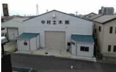
本社丸セパアングル保管場所
